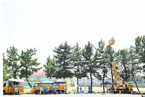
高所作業車に乗って 高いところに移動している様子
