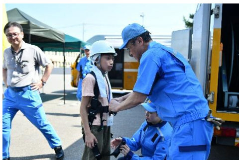
高所作業車に乗る前の安全確認作業中 「これで大丈夫。」
